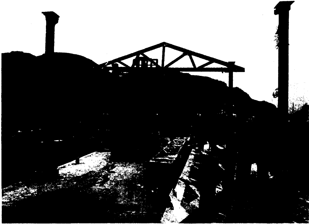
Izaje de tijerales sobre columnas de acero
