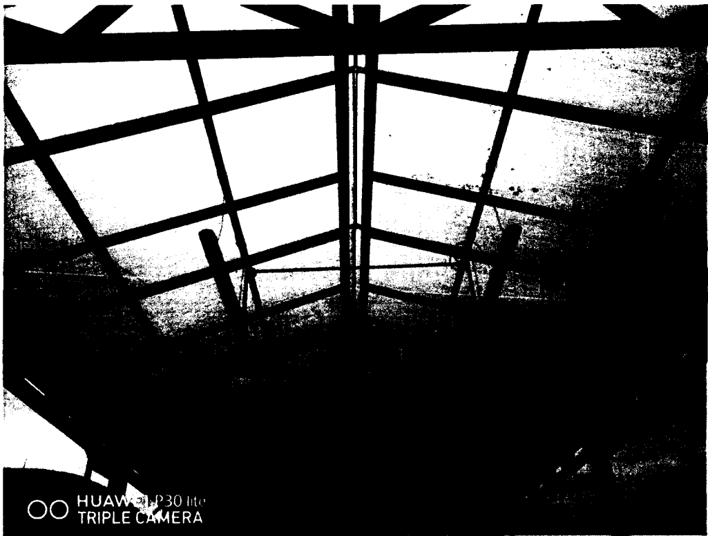
Colocación de cobertura transparente de policarbonato
