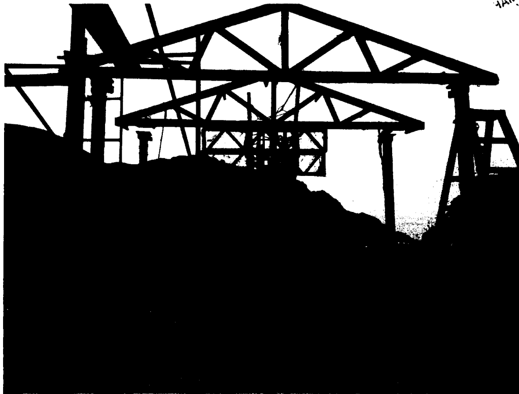
Izaje de tijerales sobre columnas de acero
