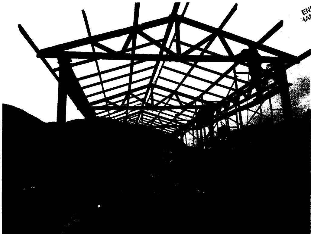
Izaje de correas de acero y soldadura en uniones
