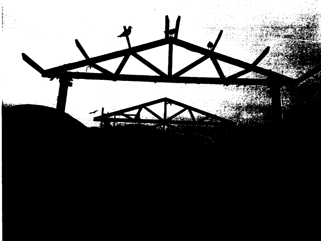
Izaje de tijerales sobre columnas de acero
